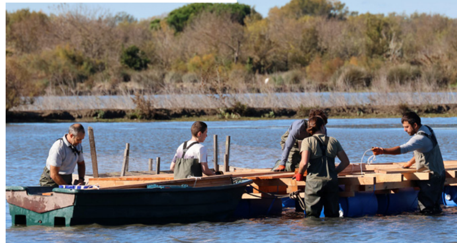
Mise en place du radeau flottant de 20 m 2 rempli de sable coquillier
